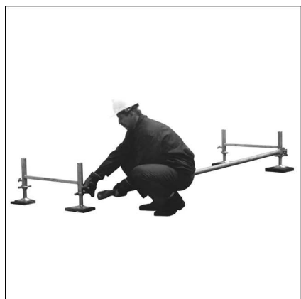
Rys.3. Zakładanie stężenia poziomego
