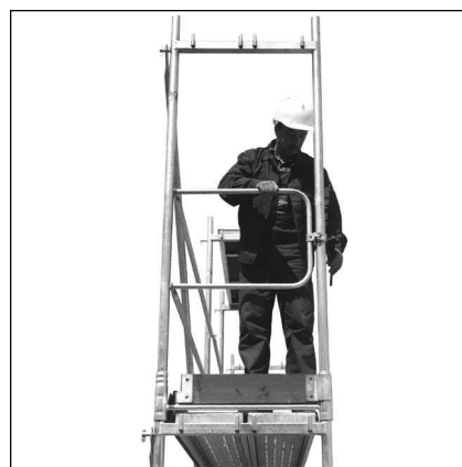
Rys.14. Montaż poręczy poprzecznej
