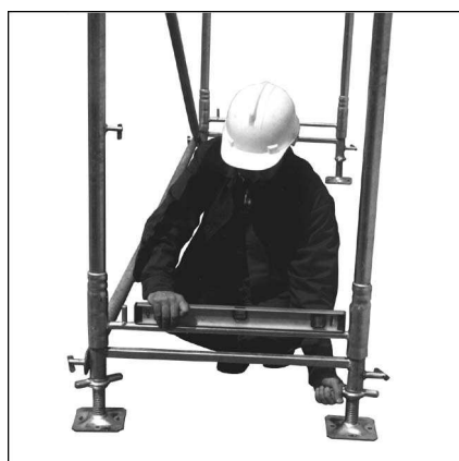
Rys.8. Kompletny pierwszy poziom rusztowania
