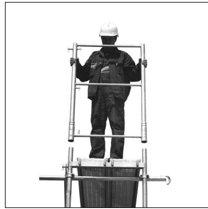
Rys. 16. Zakładanie ramki górnej
