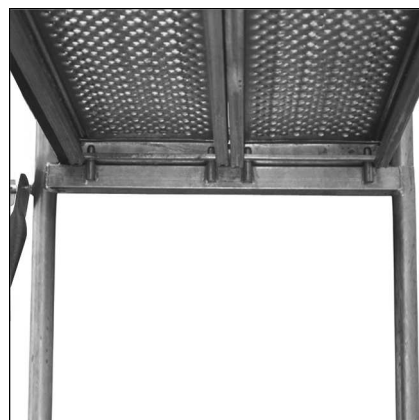
Rys.6. Pierwsze pole rusztowania z nałożonymi podestami
