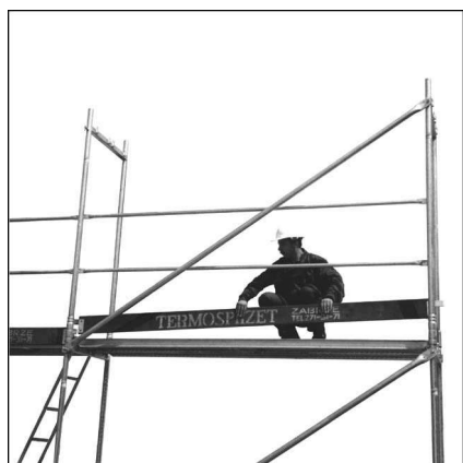
Rys.13. Zakładanie deski burtowej
