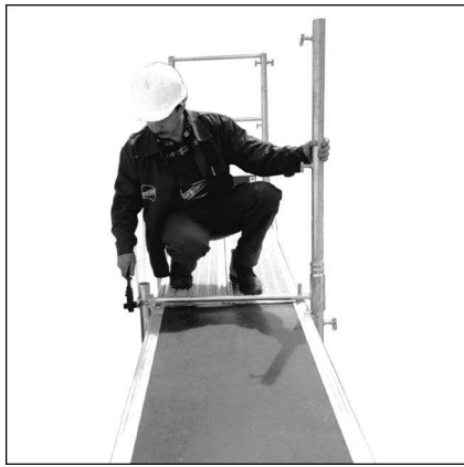
Rys. 15. Montaż ramki L
