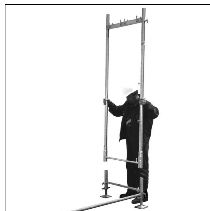
Rys.4. Montaż ramy na nakładkę podstawki śrubowej
