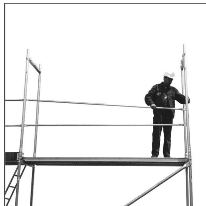
Rys.12. Montaż poręczy drugiej kondygnacji
